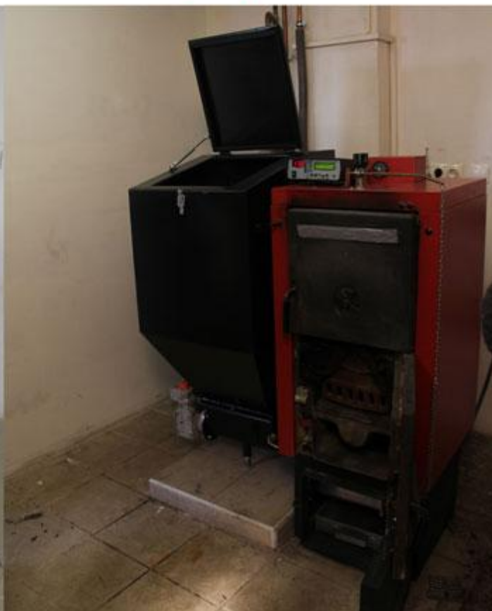
Kotel po přestavbě
