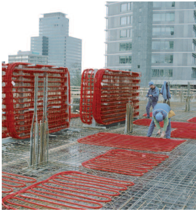
Temperování nosných betonových konstrukcí
