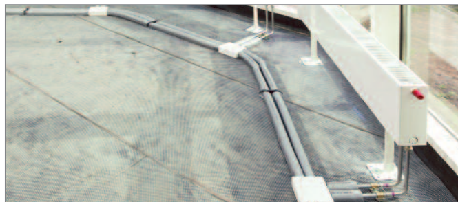
Příklad napojení otopných těles
