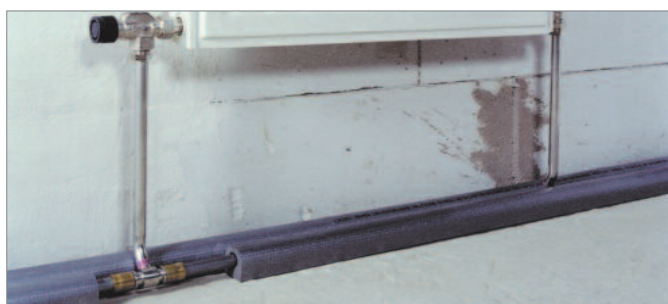
Připojení otopného tělesa pomocí T-připojovací garnitury RAUTITAN
