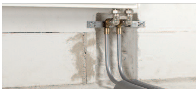
Připojení otopného tělesa pomocí montážní jednotky pro topení RAUTITAN
