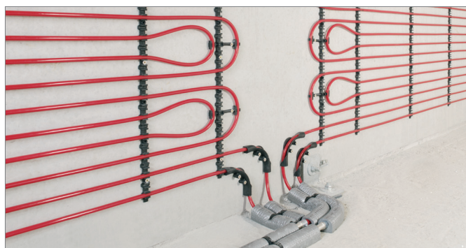
Stěnové vytápění / chlazení v mokré konstrukci
