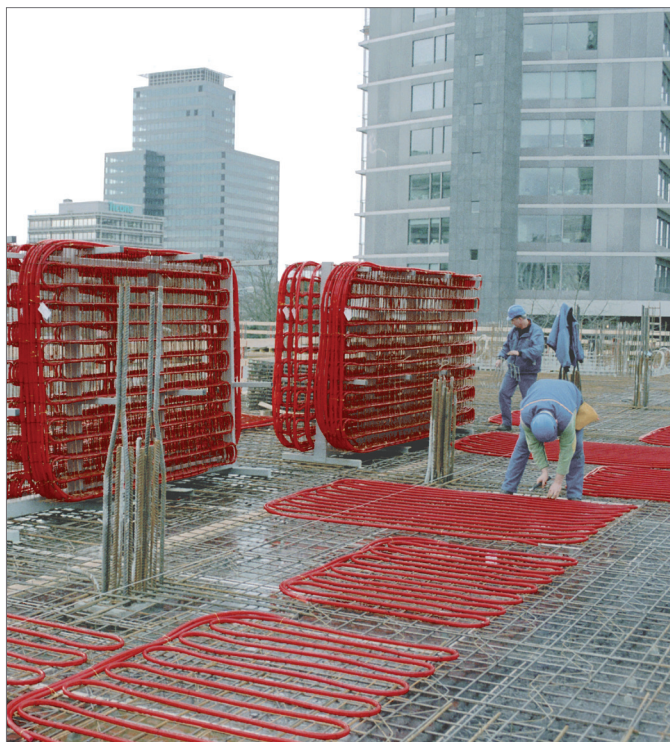
Temperování nosných betonových konstrukcí
