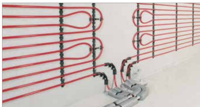
Stěnové vytápění / chlazení v mokré konstrukci
