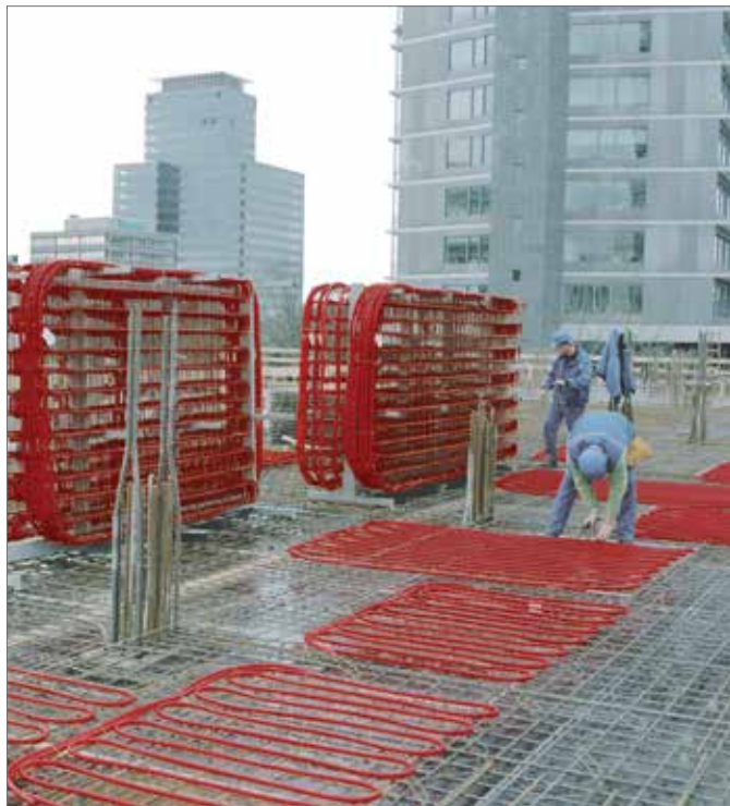
Temperování nosných betonových konstrukcí
