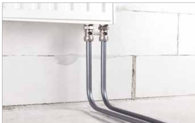
Napojení otopného tělesa univerzální trubkou RAUTITAN stabil
