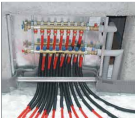
11. Instalace ochranných trubek
