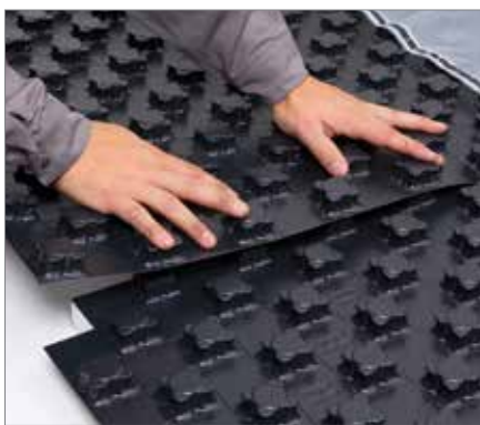
5. Instalace systémové desky na podklad
