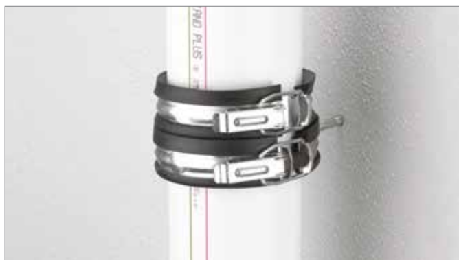
3. Hotové nainstalované podpůrné upevnění
