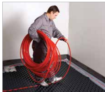
9. Pokládka trubky RAUTHERM S
