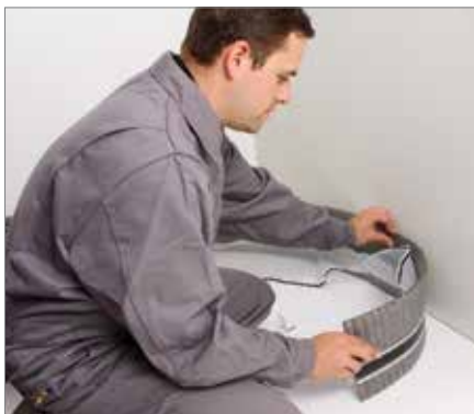
2. Instalace dilatační pásky na stěnu místnosti
