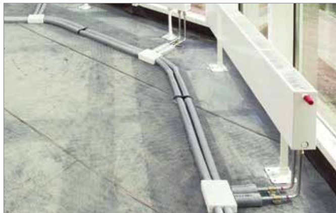
Napojení otopného tělesa univerzální trubkou RAUTITAN
