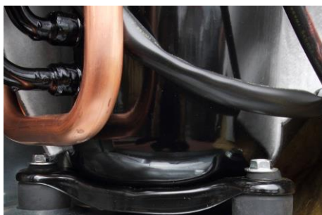
Obrázek 18: Uchycení kompresoru na rám venkovní jednotky
