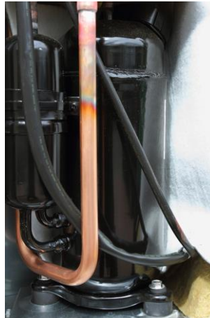
Obrázek 17: Dvojitý rotační kompresor Toshiba (bez izolace)
