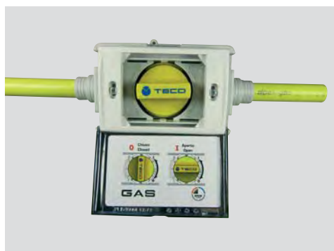
Pohled na zkompletovaný kulový podomítkový uzávěr K2-F s otevřenými dvířky K2-PL v chromovém provedení
