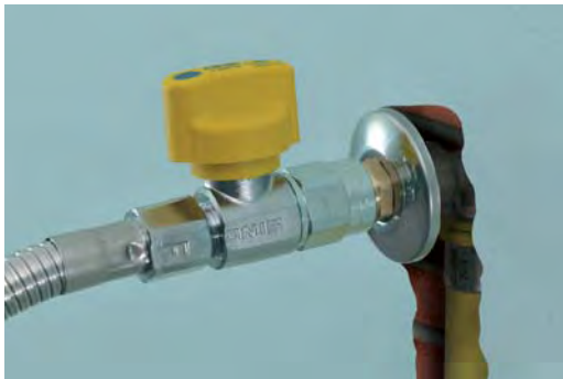
Připojení koncového plynového spotřebiče pomocí kulového uzávěru a hadic FLEXIGAS
