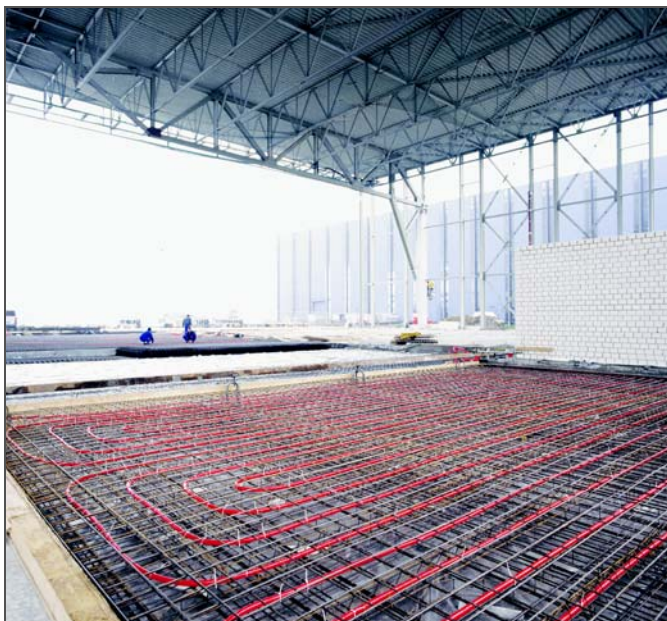
Obr. 9-1 Plošné vytápění v průmyslové hale
