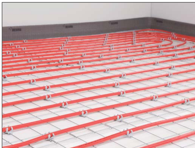
Obr. 3-43 Systém REHAU - nosná rohož
