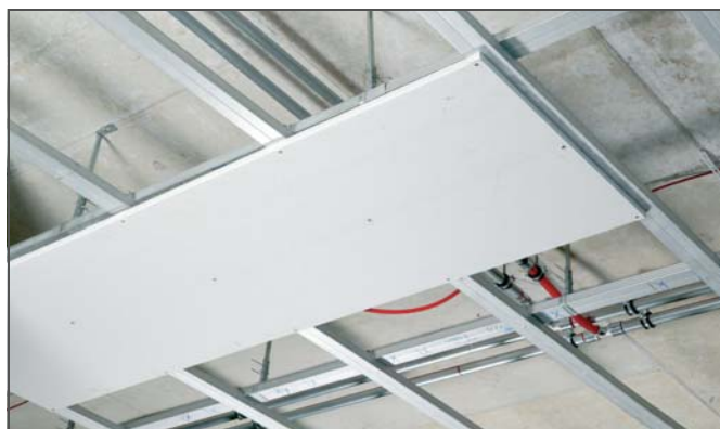
Obr. 4-34 Namontovaná stěnová deska na stropě
