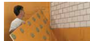
Podklad pro obkládání / konstrukční deska / kontaktní izolace
